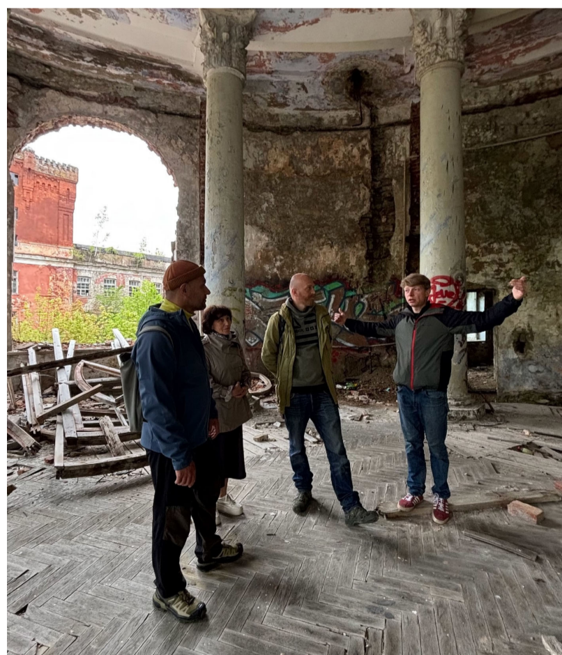
Осмотр текущего состояния газгольдера
