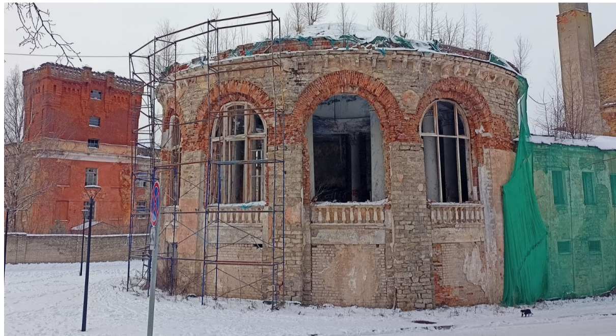
Газгольдер в лесах перед реконструкцией
